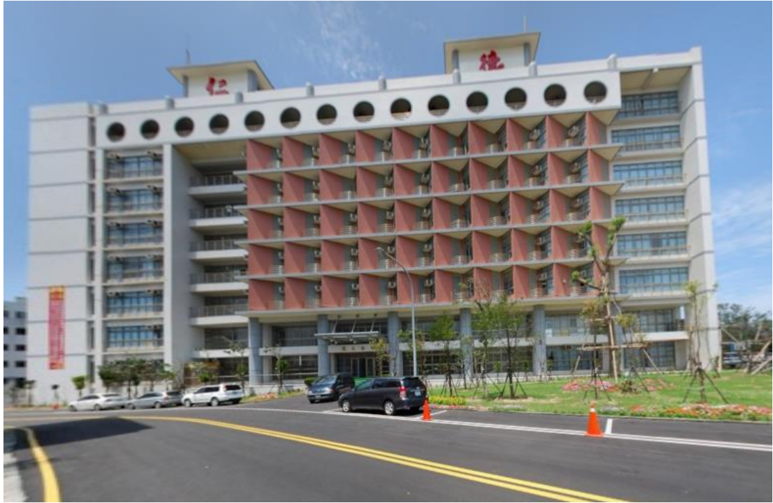
圖 1-1-1 仁德醫護管理專科學校行政大樓正面照片
